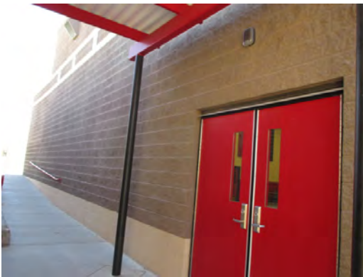
Polk ES - Exterior Gym Door
