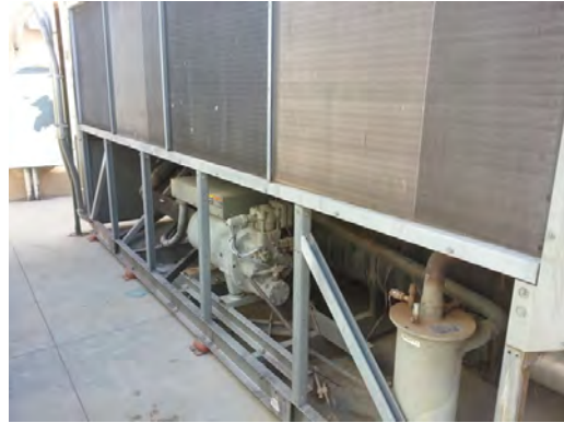
Aoy ES - Trane Chiller #1
