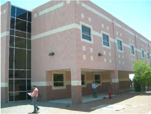
Chapin HS - Bldg 4 Exterior
