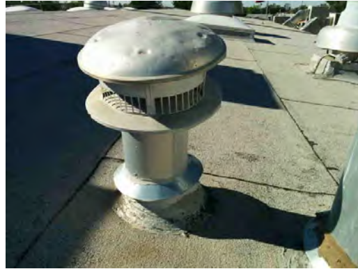
Dowell ES - Exhaust Fan
