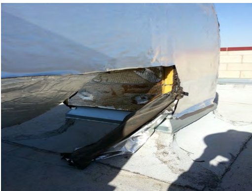
Mesita ES - Loose Insulation 02
