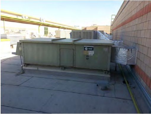
Aoy ES - Trane Air Handler
