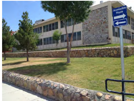
Coronado HS - Exterior
