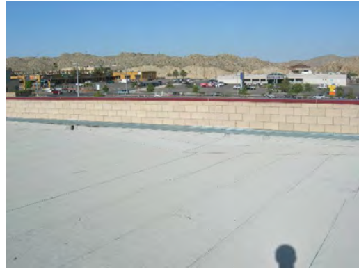
Mesita ES - Roof General Condition 02
