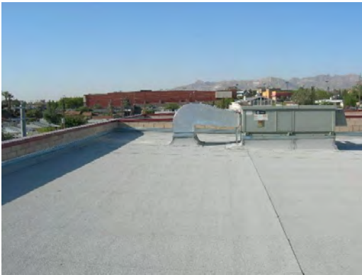
Mesita ES - Roof General Condition 03
