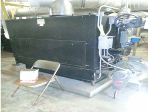
Crosby ES - Boiler 02
