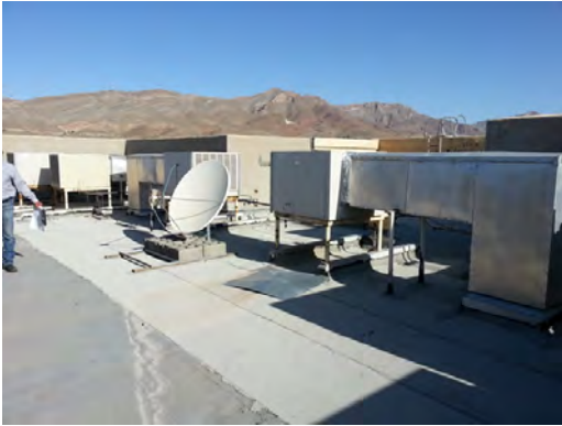
Alta Vista ES - Roof Top
