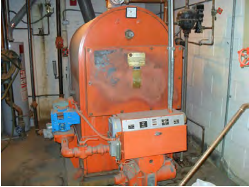
Roberts ES - Boiler
