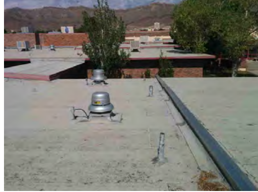
Travis ES - Roof Exhaust Fan
