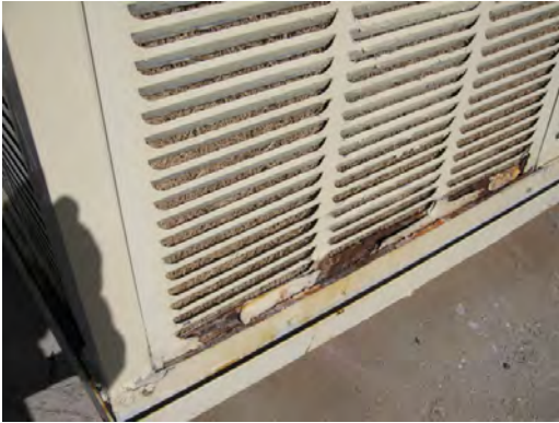
Schuster ES - Corroded Evap 02
