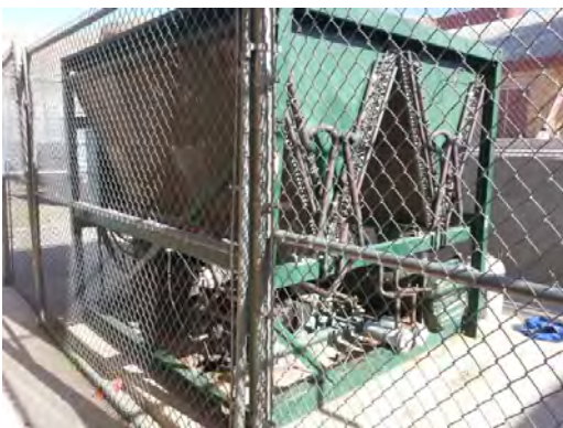
Clendenin ES - York Chiller
