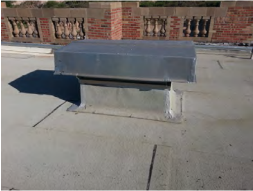
El Paso HS - Penthouse Ventilator
