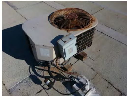
El Paso HS - Weathered Condenser
