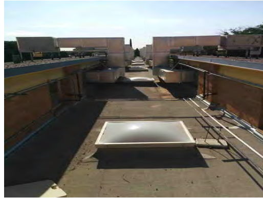
Hughey ES - Skylight
