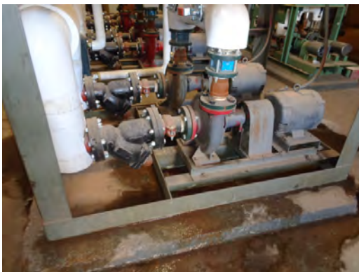
Coronado HS - Pumps
