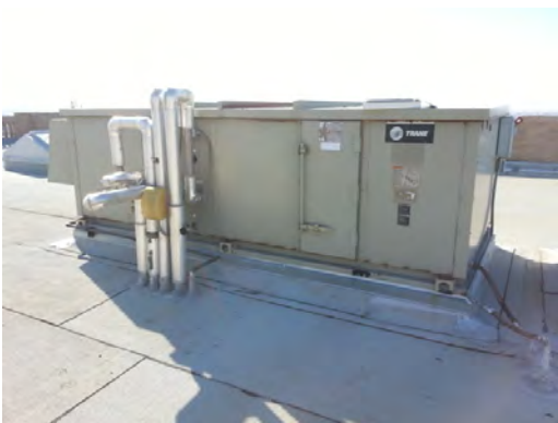
El Paso HS - Rooftop AHU
