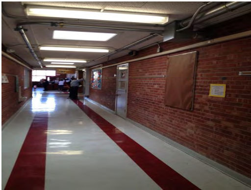
Milam ES - Hallway Finishes
