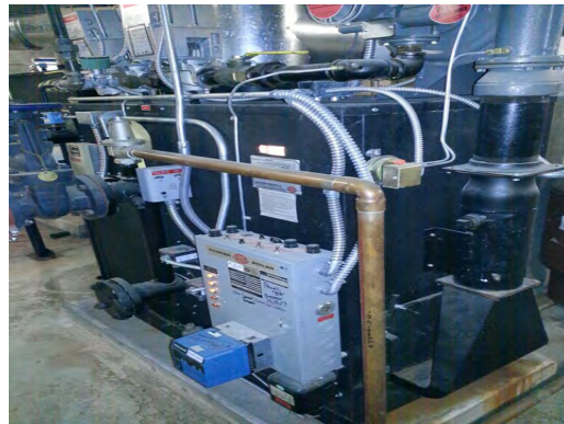
Crosby ES - Boiler 01
