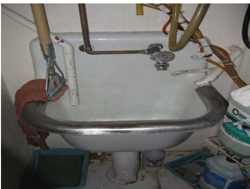
Schuster ES - Makeshift Plumbing
