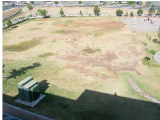
Mesita ES - Site Drainage Issues
