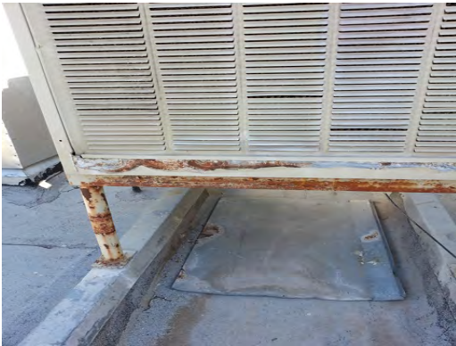
Alta Vista ES - Rusted Evap
