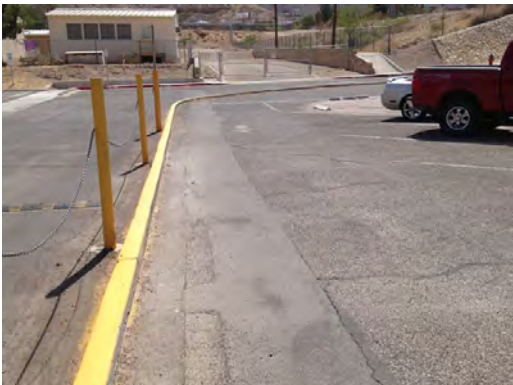
Johnson ES - Paving
