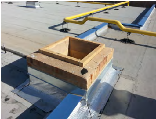
Clendenin ES - Chimney
