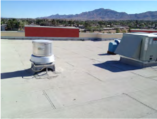
Coronado HS - Roof Exhaust Fan
