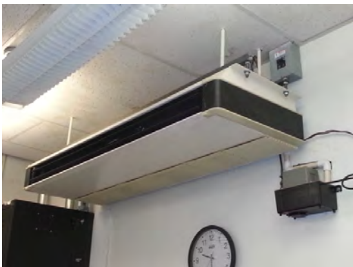
El Paso HS - Computer Lab Fan Coil
