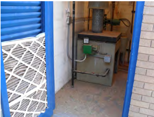
Newman ES - Boiler
