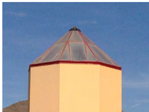
Whitaker ES - Skylight
