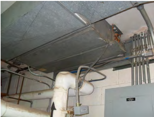
Roberts ES - Fan Coil Unit
