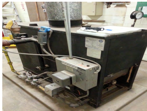
Rusk ES - Parker Boiler
