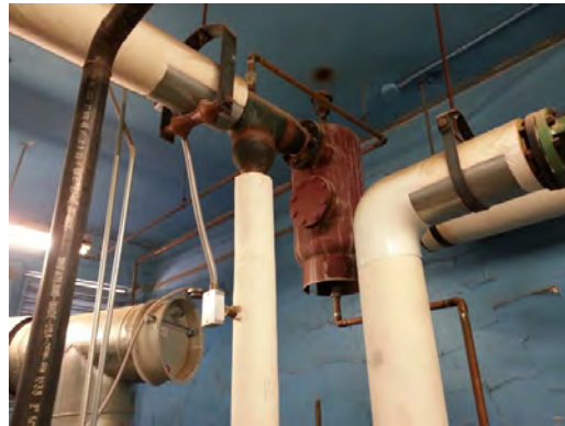
Alta Vista ES - Expansion Tank
