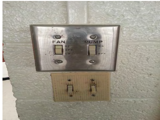
Burleson ES - Evap Cooler Switch
