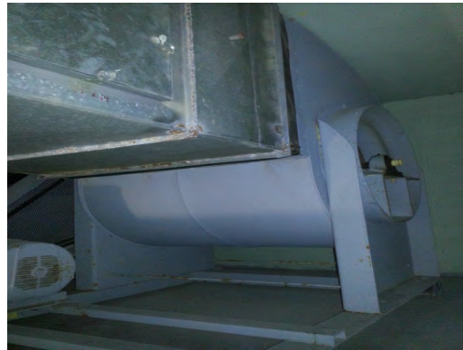
Cielo Vista - Evap Fan 02
