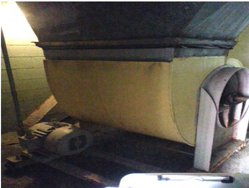
Cielo Vista - Evap Fan 01
