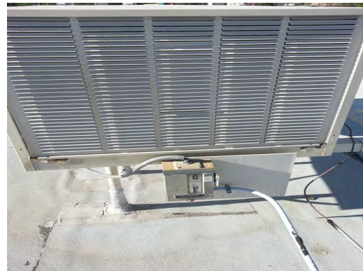
Burleson ES - Broken Flex Conduit
