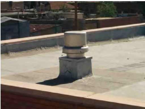
Beall ES - Roof Exhaust Fan
