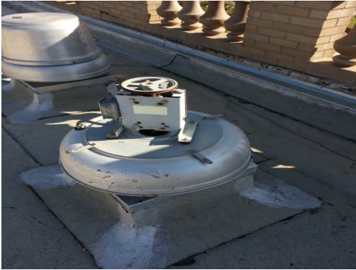
El Paso HS - Damaged Exhaust Fan 02
