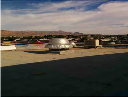
Irvin HS - Damaged Exhaust Fan
