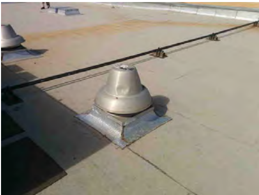
Vilas ES - Roof Exhaust Fan
