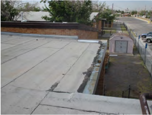
Clardy ES - Roof Gutter
