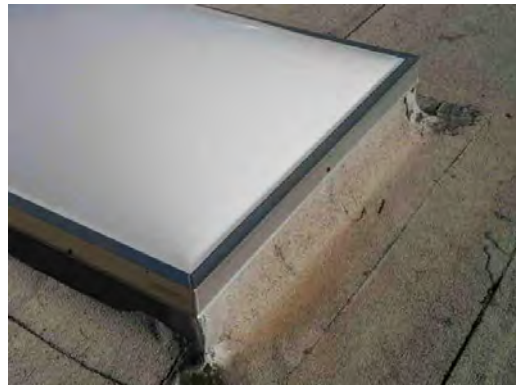
Dowell ES - Skylight
