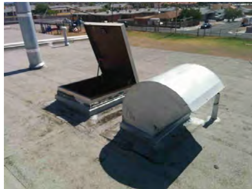
Travis ES - Roof Hatch
