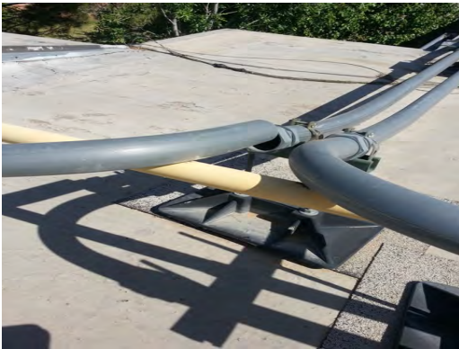
Crosby ES - Disconnected Conduit
