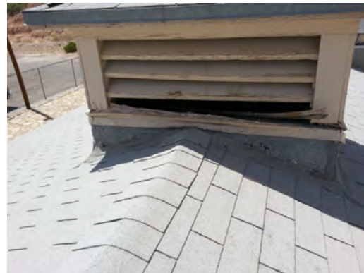
El Paso HS - Broken Vent
