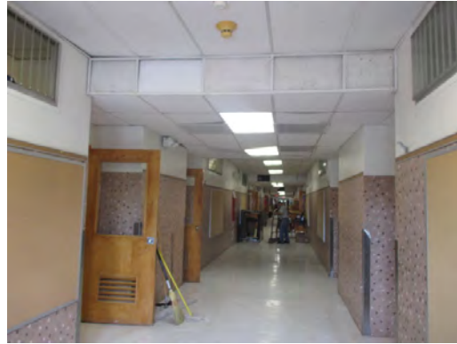
Clardy ES - Hallway Finishes
