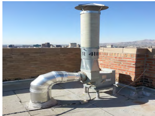
El Paso HS - Exhaust Fan
