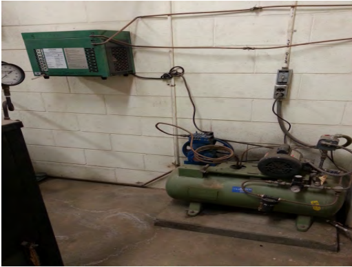
Rusk ES - Pneumatic Compressor 01
