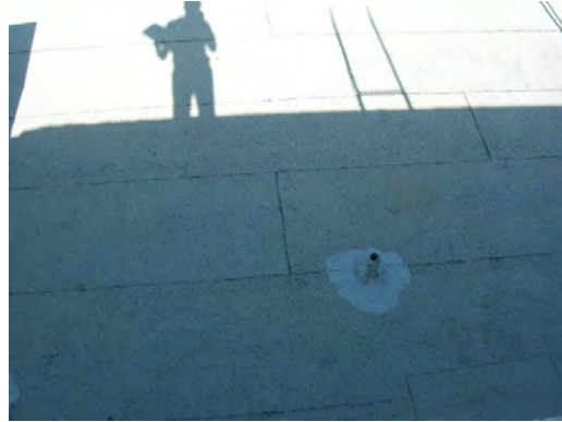
Alta Vista ES - Roof
