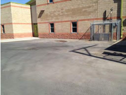
Aoy ES - Asphalt Paving
