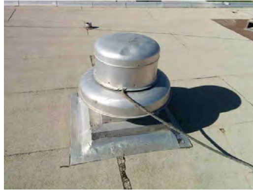
Lamar ES - Roof Exhaust Fan
