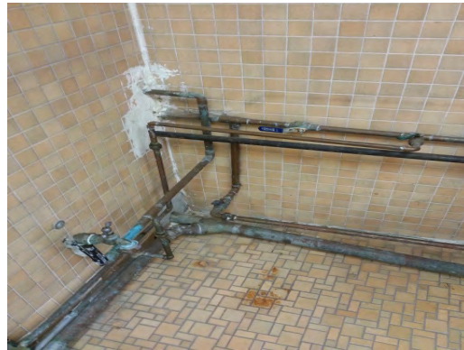
Rusk ES - Bad Plumbing
