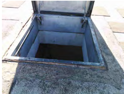
Lamar ES - Roof Hatch
