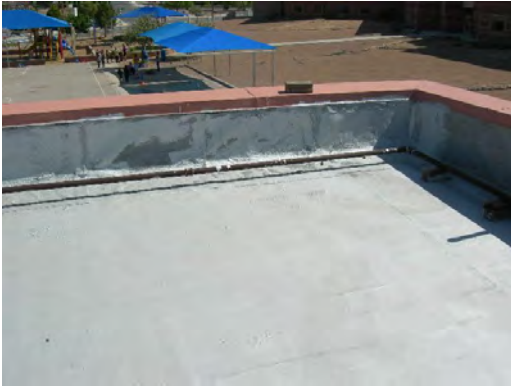
Mesita ES - Roof General Condition 01
