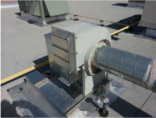
Chapin HS - Exhaust Fan
