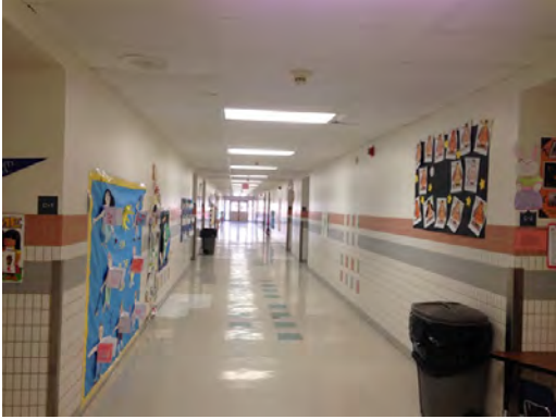
Nixon ES - Corridor Finishes
