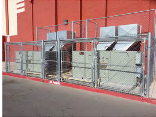
Coronado HS - Auditorium Air Handlers
