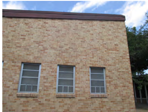
Clardy ES - Exterior Brick
