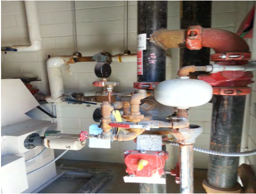
Green ES - Fire Riser
