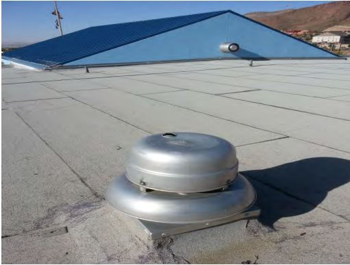
Clendenin ES - Broken Exhaust Fan
