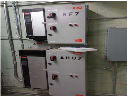
Cielo Vista - Motor Controller
