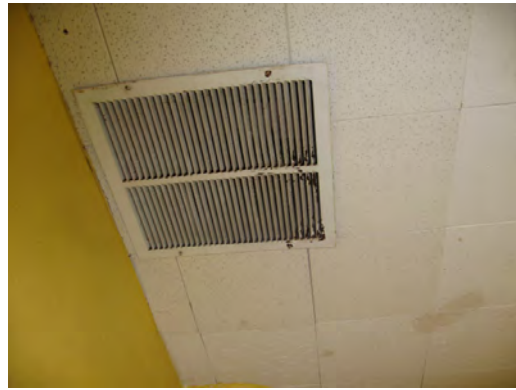
Schuster ES - Rusted Grille
