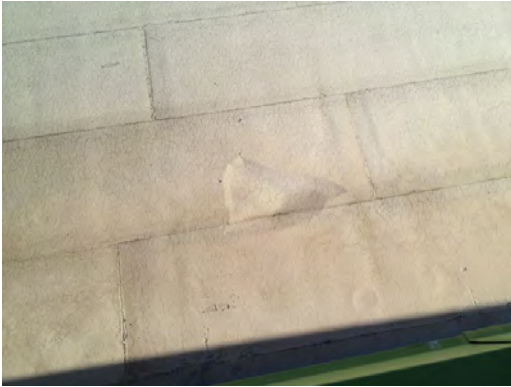
Aoy ES - Roof Bubbling
