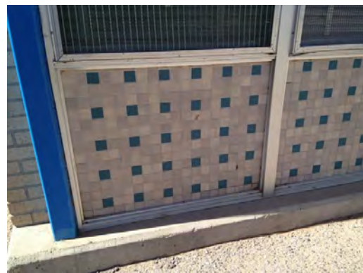
Collins ES - Exterior Tile
