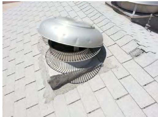
El Paso HS - Damaged Exhaust Fan
