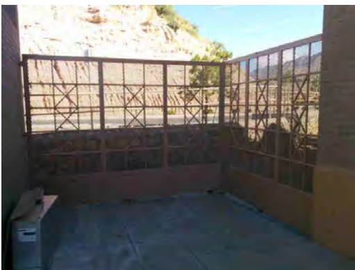
El Paso HS - Ornamental Fencing
