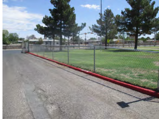
Clardy ES - Asphalt Paving
