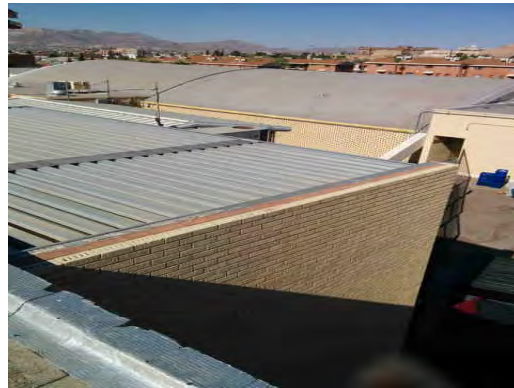
Lamar ES - Metal Roof
