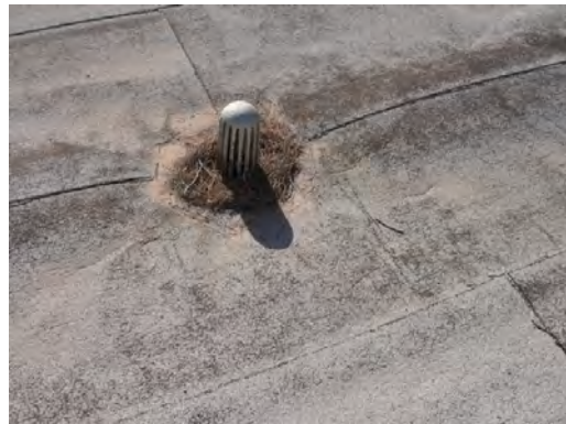
Schuster ES - Roof Drain
