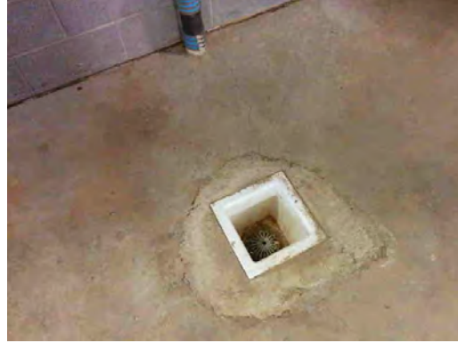
Herrera ES - Floor Drain
