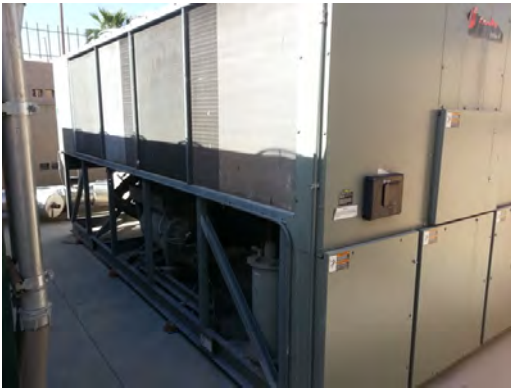
Aoy ES - Trane Chiller #2
