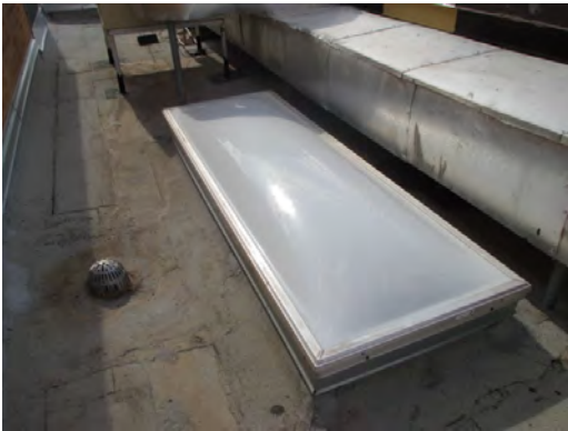
Clardy ES - Skylight
