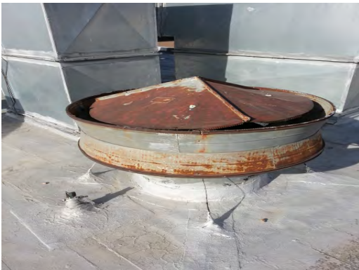
Rusk ES - Rusted Vent
