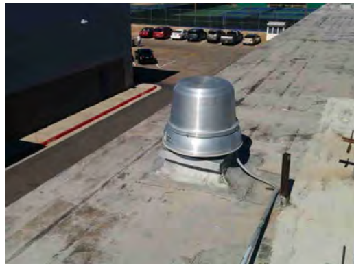
Irvin HS - Exhaust Fan
