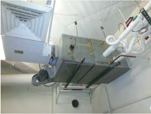
El Paso HS - Exposed Air Handler
