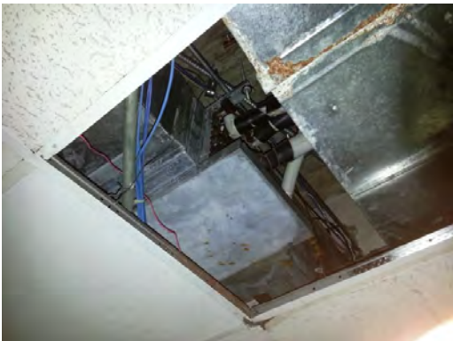
El Paso HS - Damaged Ductwork
