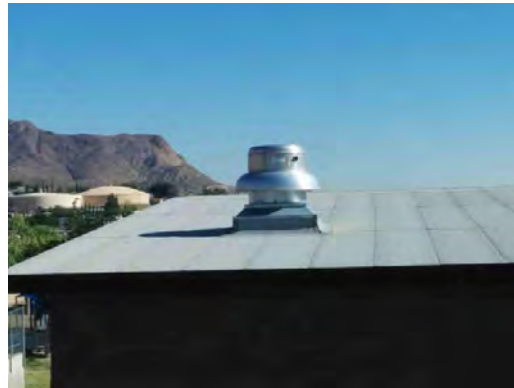
Park ES - Roof Exhaust Fan
