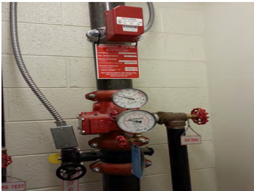
Alta Vista ES - Fire Riser
