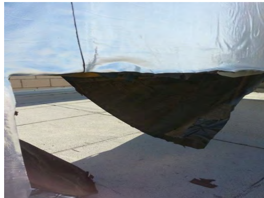
Mesita ES - Loose Insulation 01
