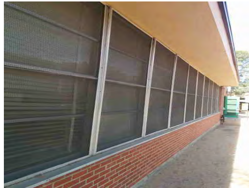
Hawkins ES - Exterior Metal Windows
