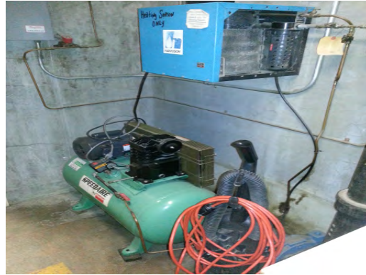
Rusk ES - Pneumatic Compressor 02
