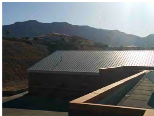
Tippin ES - Metal Roof
