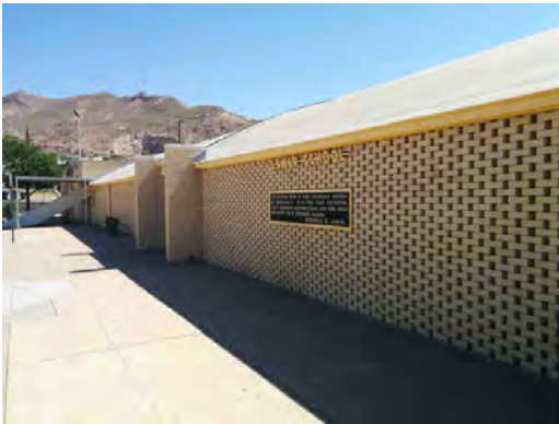
Lamar ES - Exterior Brick
